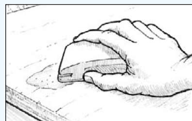
Figur 23 Slipa spacklet jämnt med omgivande yta.
